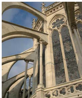
Basilique de Saint-Denis - Restauration des travées du chevet
